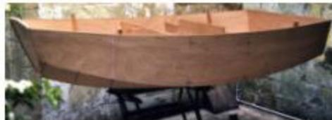
Собрав вместе все компоненты в узнаваемые очертания лодки, я проверил эту шаткую конструкцию на соответствие проекту и произвёл небольшую подгонку. Концы бортов, имеющие тенденцию выступать на переднем транце, укрепил временными винтами с шайбами под головками
