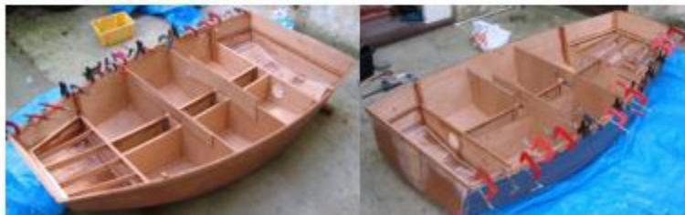
Наружный привальный брус был слоистым из двух реек красного дерева. Я закрутил кромки основания реек так, чтобы нижняя часть была приблизительно горизонтальна, когда рейки были изогнуты вокруг корпуса.
